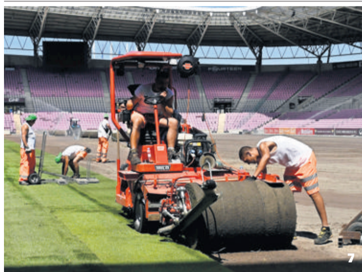
1. Au lendemain du Suisse-Belgique du 28 mai, la pelouse et son substrat sont raclés sur 35 centimètres. 2. Le système de drainage est recouvert. 3. Place aux tubes de chauffage, un véritable radiateur qui sera sous la pelouse. Cela représente 27 kilomètres de tubes de 2 centimètres de diamètre. 4. Du sable recouvre ensuite les tubes chauffants sur 15 centimètres de haut. 5. Du sable de quartz est ensuite disposé sur la couche précédente. 6. Les derniers centimètres de sable de quartz sont mélangés avec un compost qui contient des éléments organiques appelés à nourrir les racines du gazon naturel. Les rouleaux sont maintenant prêts. 7. Les ouvriers spécialisés déroulent les nombreux rouleaux, mélange pré-cultivé de pelouse synthétique et naturelle. 8. Le beau gazon est désormais prêt, majestueux, révolutionnaire.
